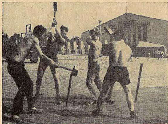
Zeltverankerungen werden eingeschlagen. Das kostet viel Schweiß.
